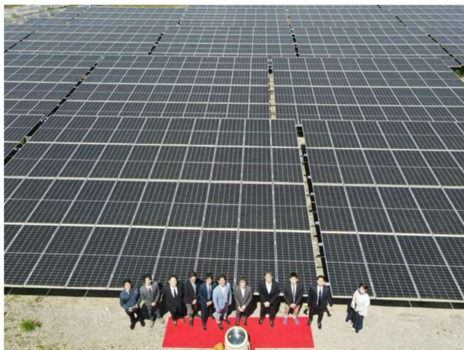
auRE 埼玉県深谷市本田 太陽光発電所 1
